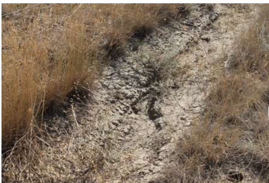
Рис. 10.14. Заращение колеи заброшенной грунтовой дороги на северном склоне г. Б. Богдо. На дне колеи видны эрозионные борозды глубиной до 15 см.
