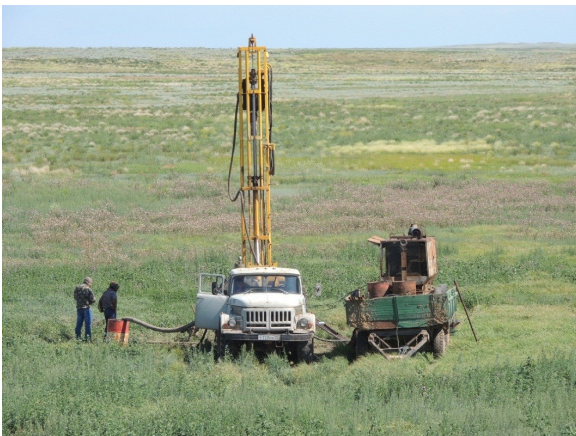
Бурение скважины. Фото Н. Пирогова. 11.06. 2021
